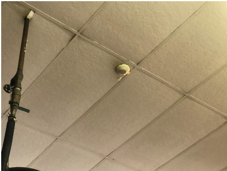
FA-3 Thermal Detector (TYP)
